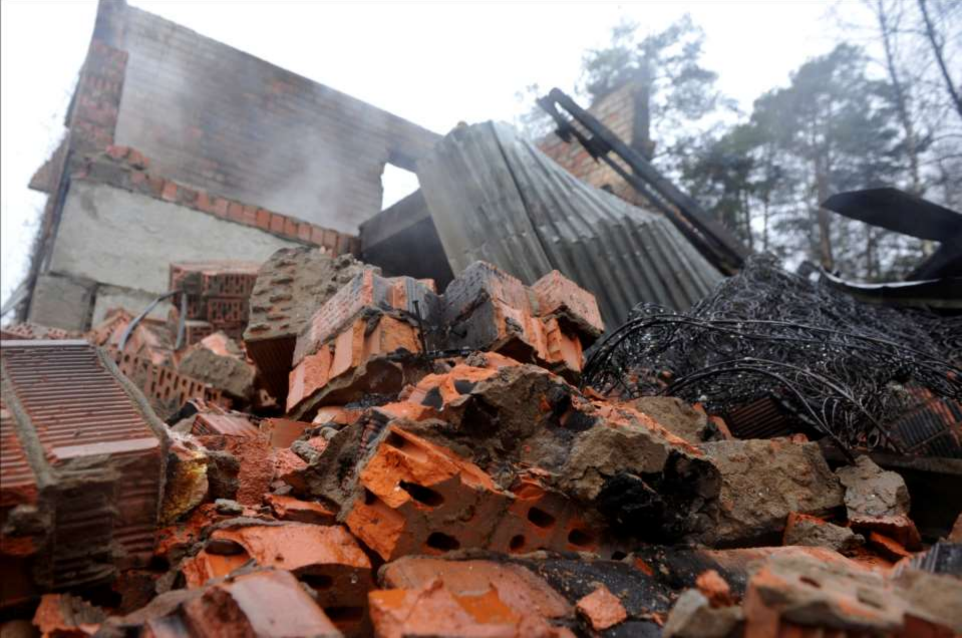
Взрыв на газопроводе в Щелковском районе Московской области в октябрь 2012 года
